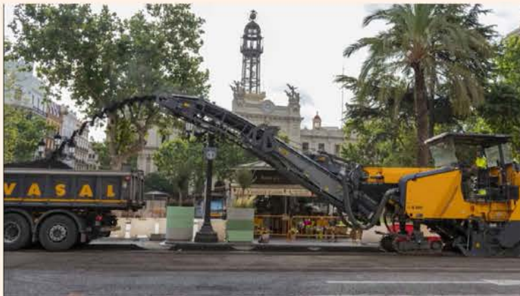
Trabajos de reasfaltado de la plaza del Ayuntamiento de Valencia.
